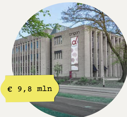
Trigon in gebruik april 2016 (renovatie)
